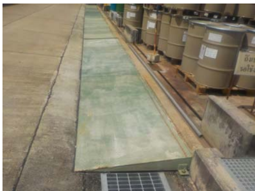
รูปที่ 3.32 Concrete Curb รอบพื้นที่เก็บพัก ของเสียประเภทบรรจุภัณฑ์สารเติมแต่งที่ใช้แล้ว
