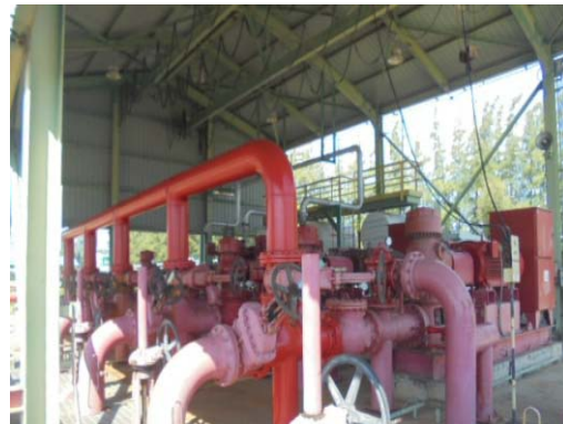
รูปที่ 3.52 บ่อน้ำสำรอง และปั๊มน้ำดับเพลิง
