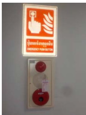
รูปที่ 3.50 ระบบตรวจจับและแจ้งเตือนไฟไหม้
