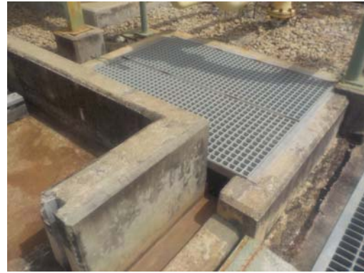
รางระบายน้ำฝนปนเปื้อน และรางระบายน้ำเสีย
